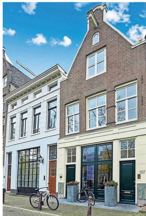
De koetsdeuren van het grachtenpand zijn in ere hersteld.
